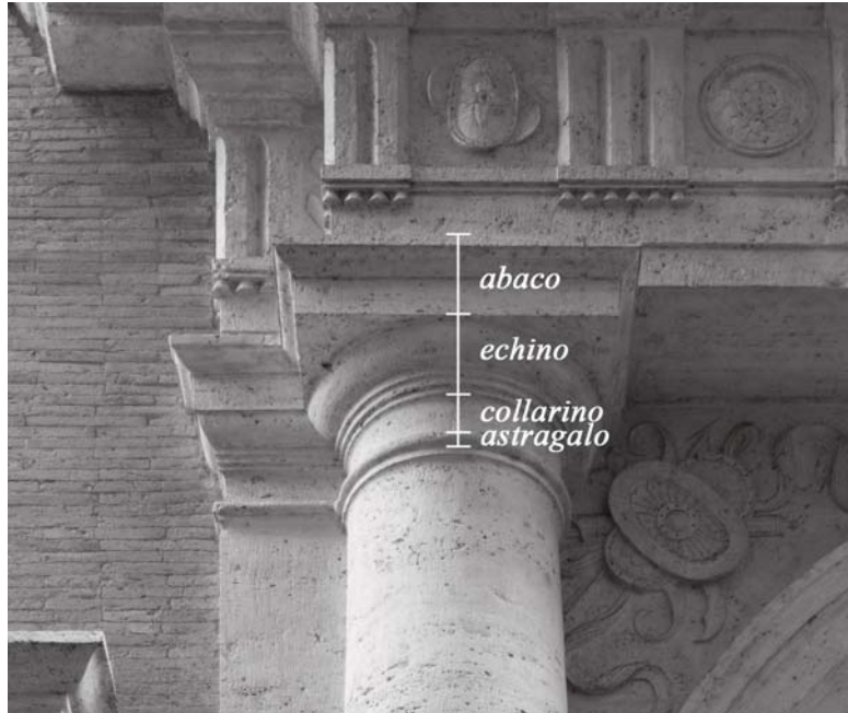
Fig. 16 Elementi ricorrenti nei capitelli toscano e dorico.
