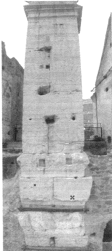
FIGURA 5.23 Roma, Colosseo. Vista interna del pilastro 1 (fornice 18)
