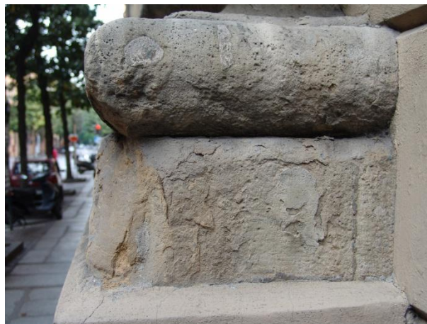
A sinistra: biocalcarenite alveolizzata.
