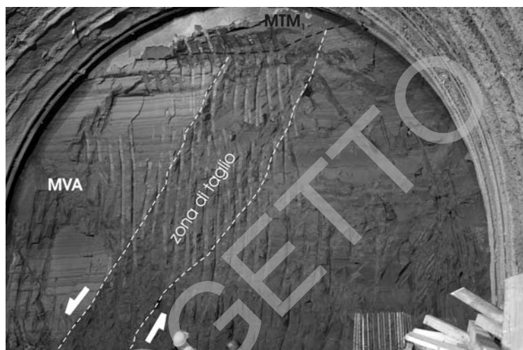
Fig. 32 - Shear zones e piani di faglia ad alto angolo attraversano la formazione di Monte Vaticano, qui a giacitura suborizzontale, e sono suturati dalla superficie di unconfirmità del Supersistema Acquatraversa. Galleria Giovanni XXIII. Cortesia Astaldi S.p.A.
