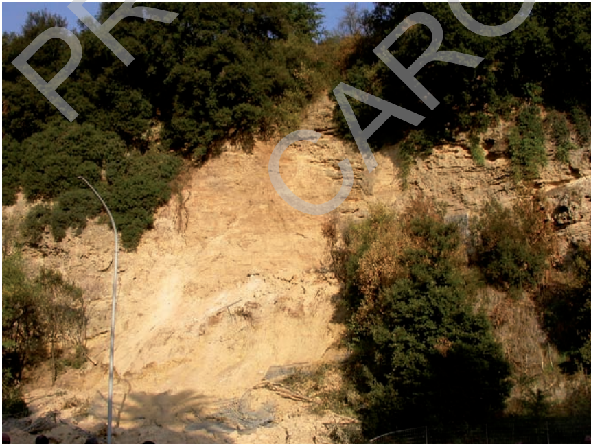
Fig. 13 – Travertini fitoclastici presso Viale Tiziano dopo l’evento di frana del 13 novembre 2007.
