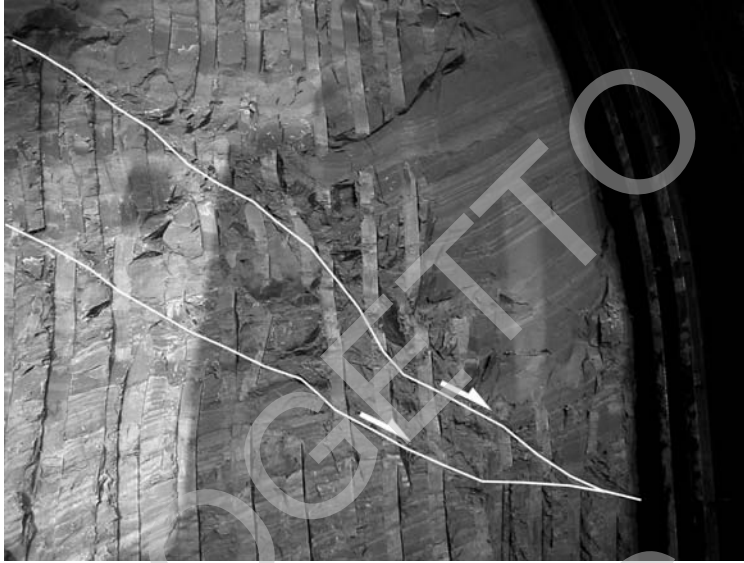
Fig. 33 - Faglie estensionali nella formazione di Monte Vaticano, a basso angolo, ma con alti angoli di cut-off. Tale geometria suggerisce un basculamento durante o dopo il processo di fagliazione. Galleria Giovanni XXIII. Cortesia Astaldi S.p.A.
