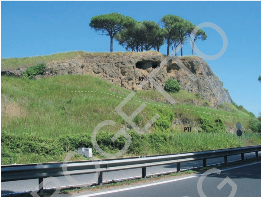
Fig. 19 – Sepolero dei Nasoni, lungo la Via Flaminia. L'unità RNR, che riempie una paleovalle molto incisa, si presenta litoide per zeolitizzazione assumendo la tipica colorazione rossa. La superficie di base coincide con l'unconformity che accoglie il sistema Torrino.
