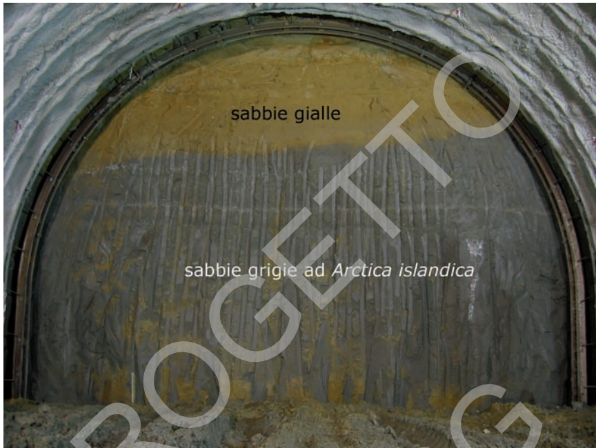
Fig. 4 – Il cambio di colore definisce il passaggio tra sabbie grigie ad Arctica islandica e sabbie gialle al di sopra del membro di Farneto della formazione di Monte Mario, a quota 62 m s.l.m. lungo la galleria “Giovanni XXIII”, sotto la collina dei Monti della Farnesina (cortesia Astaldi S.p.A.).
