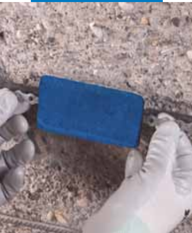
Applicazione di Mapeshield I su una struttura da ripristinare
