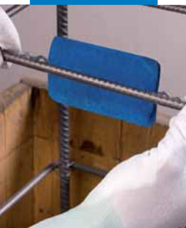
Applicazione di Mapeshield I su una struttura nuova
