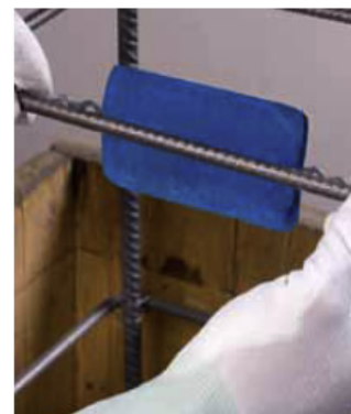
Applicazione Mapeshield su struttura nuova
