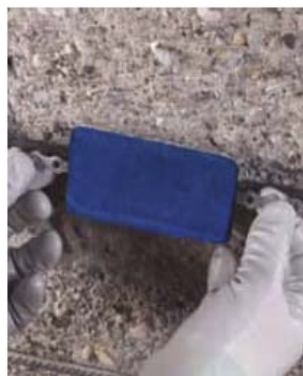
Applicazione Mapeshield su struttura da ripristinare
