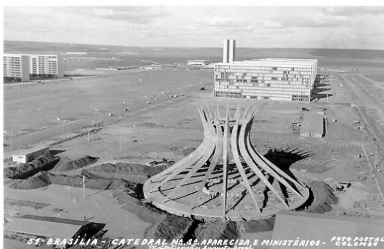
Figura 2: Catedral de Brasília, com a estrutura apenas lançada, antes da inauguração de Brasília (foto autor desconhecido)
