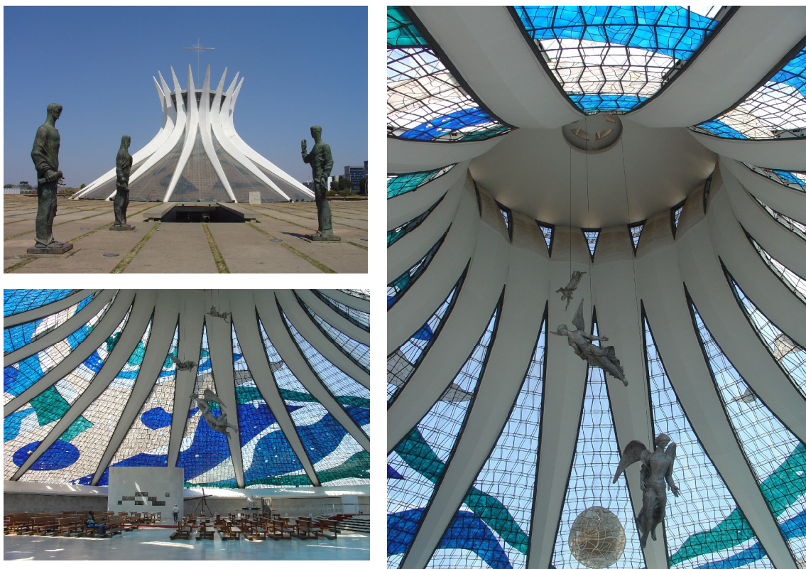
Figuras 5, 6 e 7: Catedral de Brasília atual – vista da rampa de acesso externa, espaço interior de recolhimento banhado pela luz natural, e detalhe do anel de compressão, laje de cobertura e panos de vidros entre os pilares (fotos da autora)
