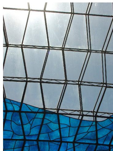
Figura 12: Detalhe da fixação dos vidros na treliça espacial (foto da autora)
