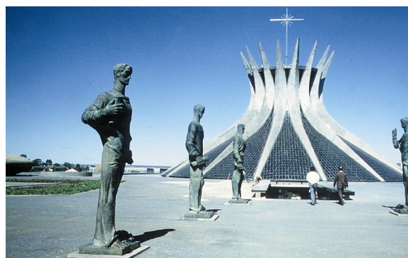
Figura 3: Catedral de Brasília, com estrutura em concreto armado aparente e fechamento lateral entre os pilares (foto Alexander Fils)
