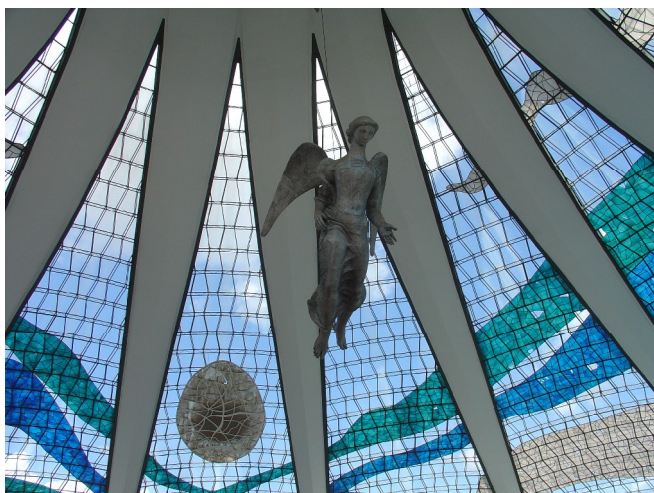
Figura 11: A malha espacial entre os pilares permite a fixação de duas camadas de vidro na estrutura hexagonal do banzo inferior e superior da treliça (foto da autora)
