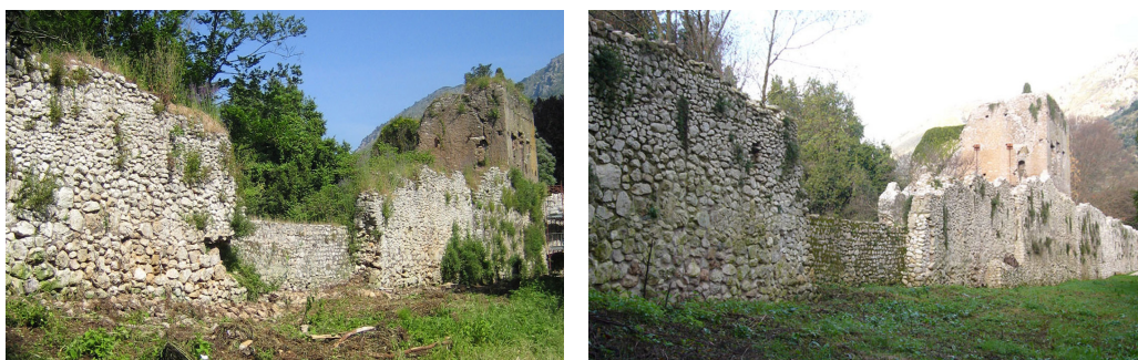
Fig. 5 – Ninfa, prospetto esterno del tratto di mura nord orientali prima e dopo l'intervento.
