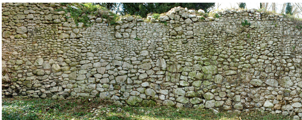
Fig. 4 – Ninfa, cinta interna. Si notano i segni della sopraelevazione (foto I. Rossi Doria).
