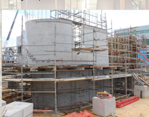
Posizionamento casseforme e rivestimento Immagini reperite dal sito della Bond University
