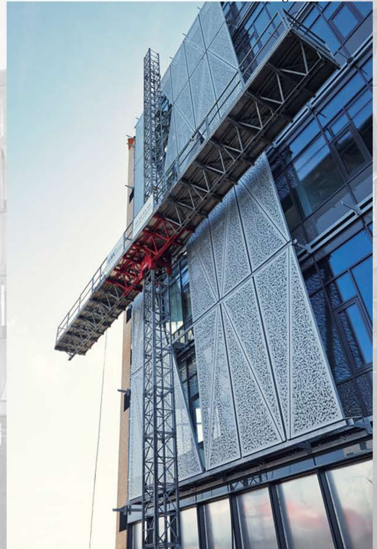
Immagine dal cantiere
