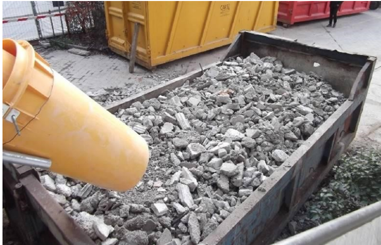
Fig.21. SCARRABILE CASSONE FOR SCARICO MACERIE
