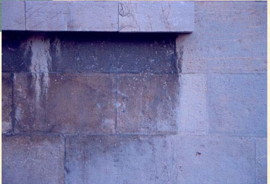
**CONCREZIONE – deposito compatto formato da elementi di estensione limitata, sviluppato preferenzialmente in una sola direzione (NorMaL 1/88)**
