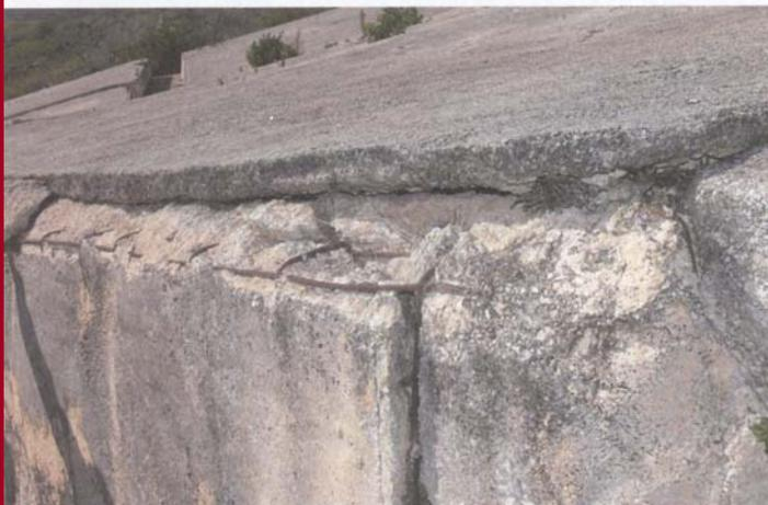
**Spostamento del muro di valle in una delle isole**
