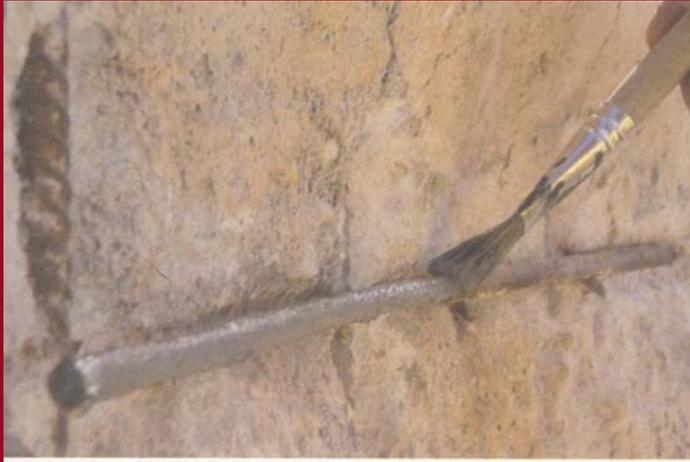
**Applicazione di inibitore di corrosione sui ferri di armatura**
