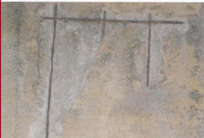
**Rimozione del calcestruzzo ammalorato sulla parete S dell'isola 55**
