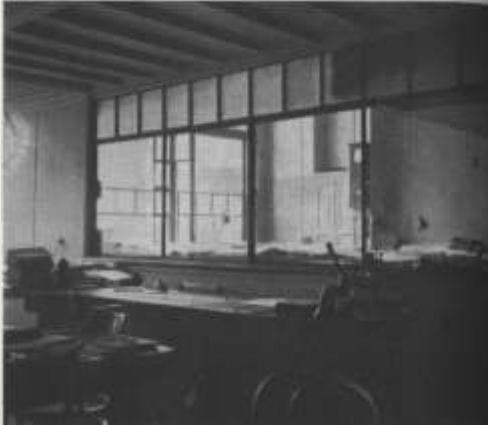
A. Perret: 1903 Rue Franklin Paris
