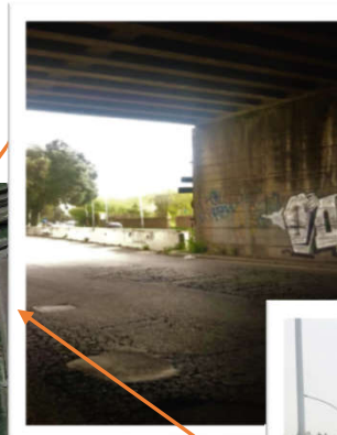
Sottopassaggio a via di Portonaccio
