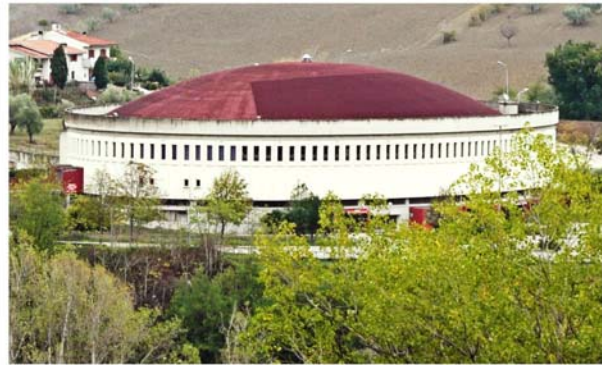
La più grande cupola a paraboloide ellittico in laterocemento mai realizzata nel mondo, costruita dall'ing. Giampiero Castellucci a Teramo nel 1980 per il Palasportino, il palazzetto dello sport. L'ellisse d'imposta del paraboloide ha assi di 63 metri e 45 metri.
