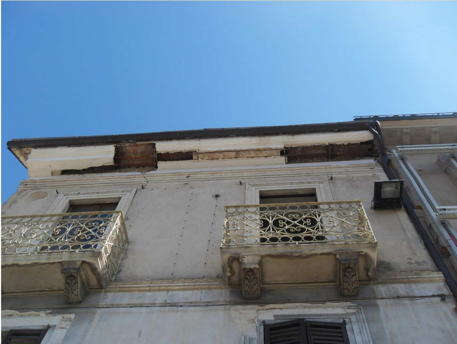
ELEMENTI DELLA FACCIATA - DISTACCO DEL CORNICIONE
