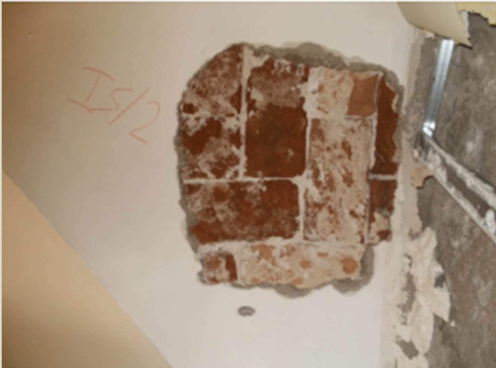
Volta a crociera con mattoni pieni disposti in folio.
