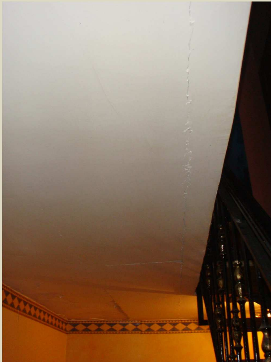
Solaio visto da una vano scala. Fessure in corrispondenza delle putrelle
