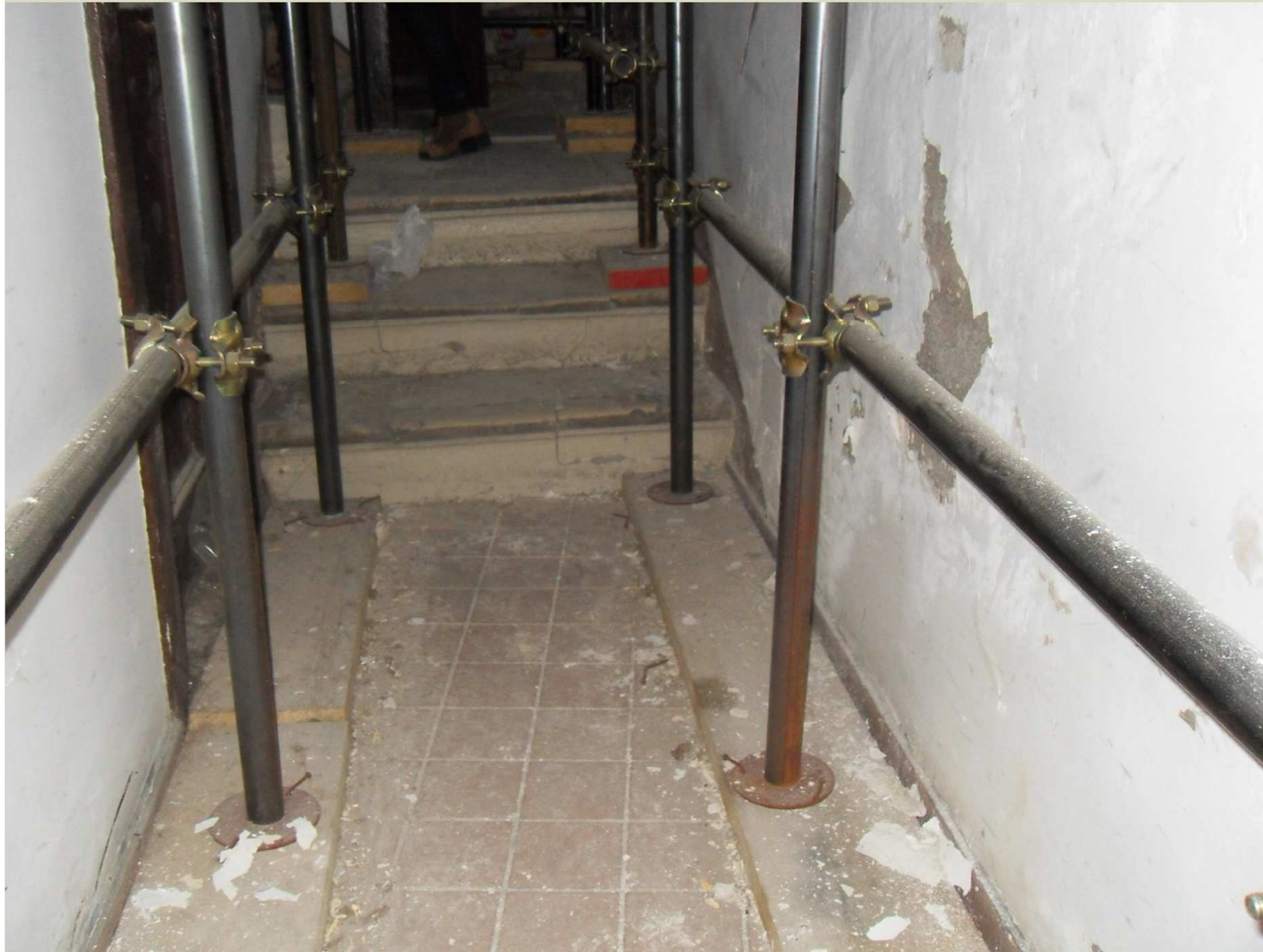
Scala in muratura con gradini lapidei da conservare
