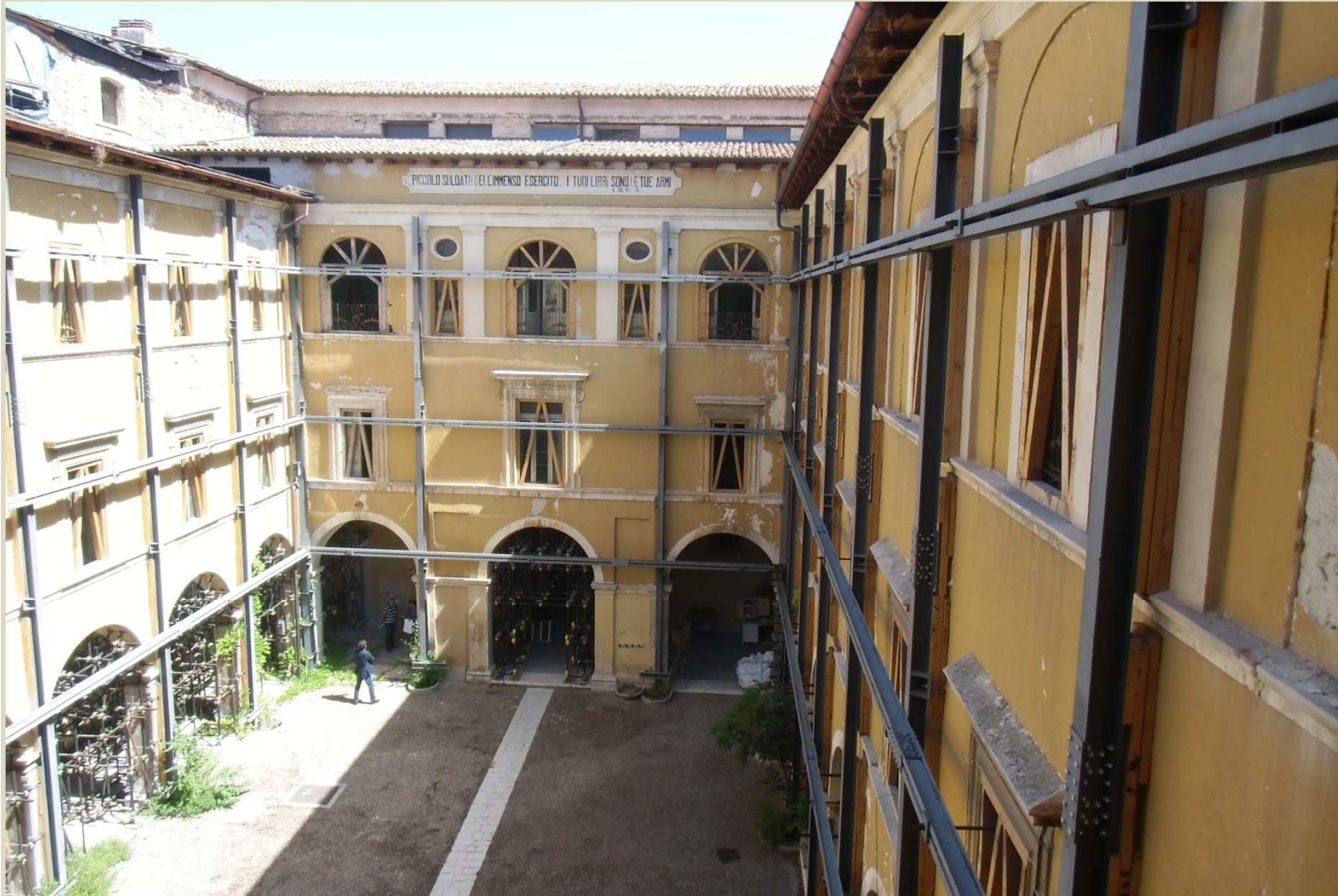
Scuola De Amicis, L'Aquila – Puntellamento della corte interna
