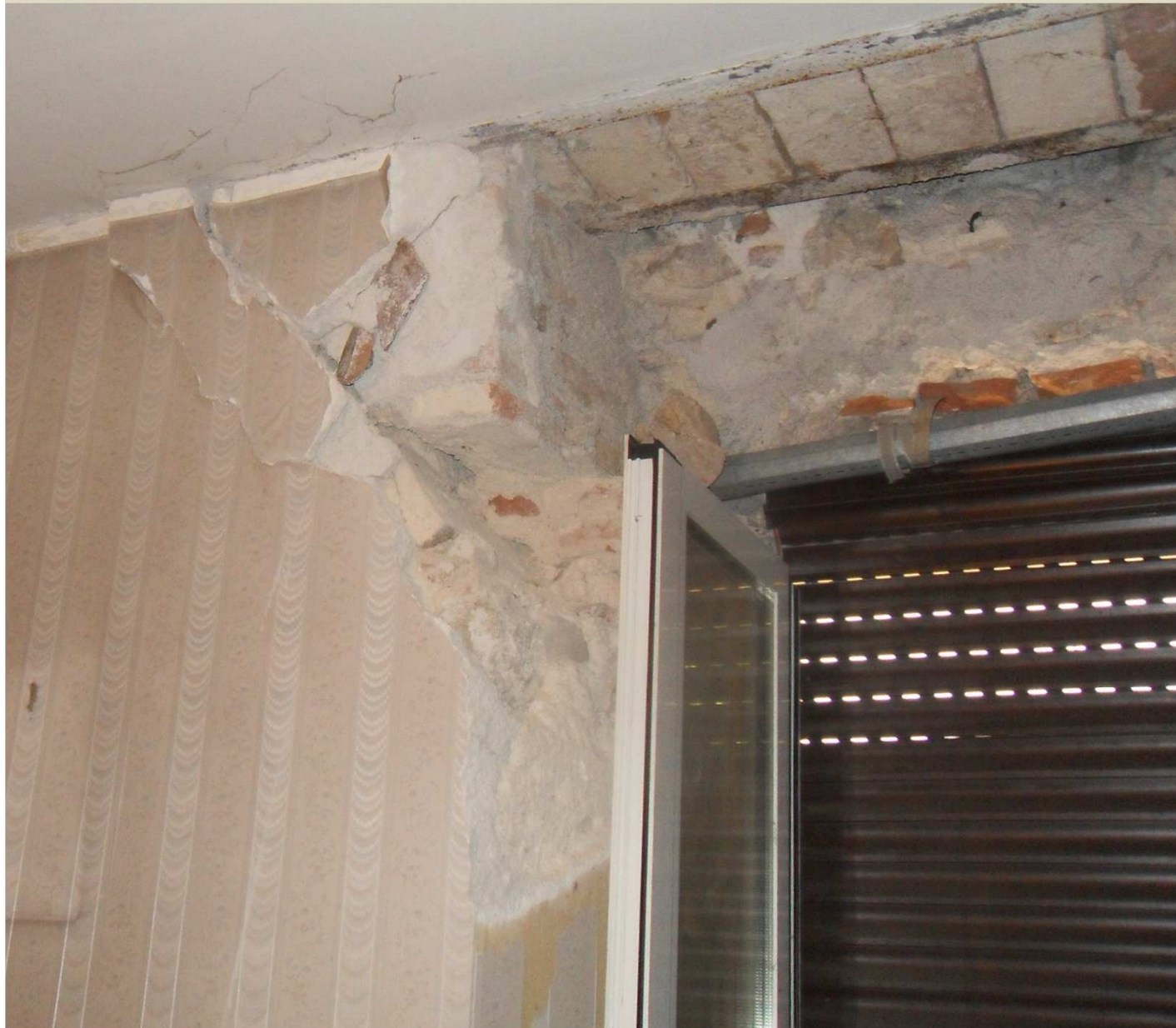
Crollo dell'architrave in muratura
