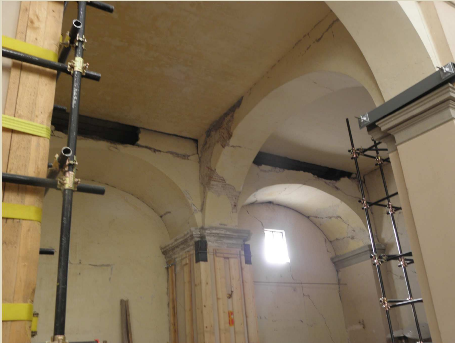
Arischia: Interno della Chiesa di San Domenico, cerchiatura dei pilastri
