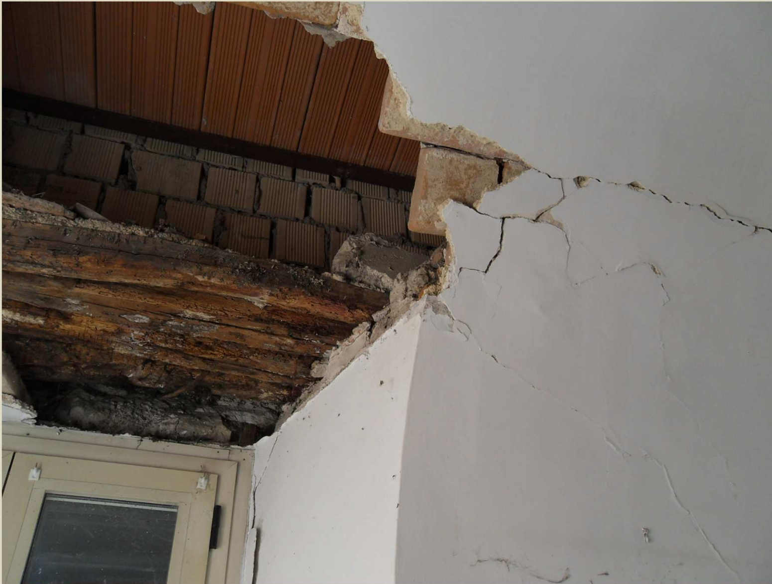
Crollo di porzione di volta a botte con mattoni pieni disposti in folio.
