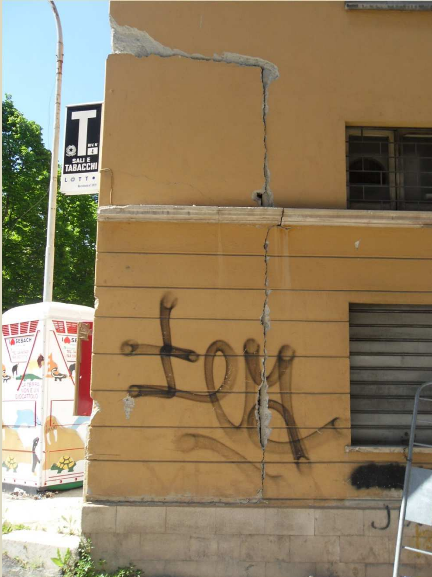
Ribaltamento composto di cuneo diagonale
