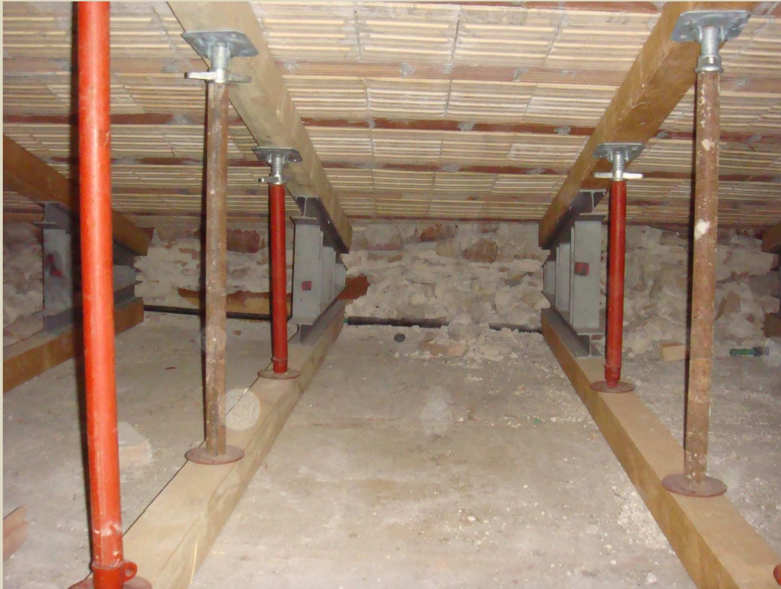
Puntellamento della copertura in laterocemento
