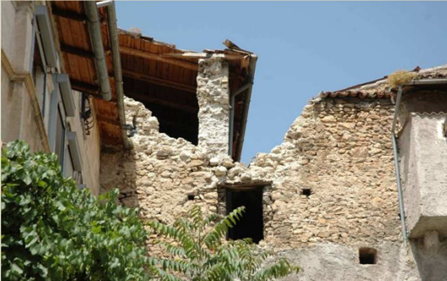
Ribaltamento della muratura per martellamento del tetto
