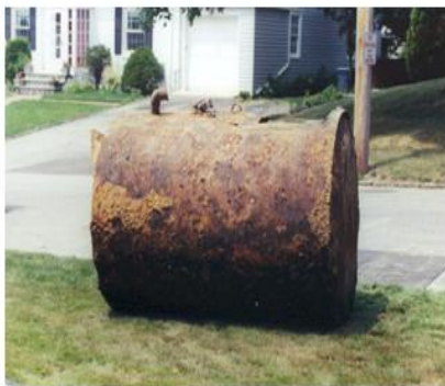
Rimozione di serbatoi di carburante interrati
