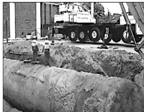
Rimozione di serbatoi di carburante interrati
