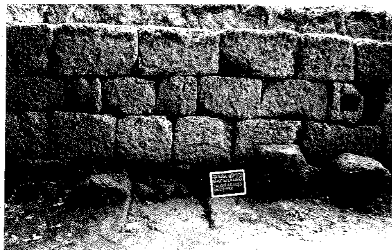
Fig. 5 Il muro in blocchi di tufo rinvenuto a La Lega a Blera. Foto P. Di Silvio.
