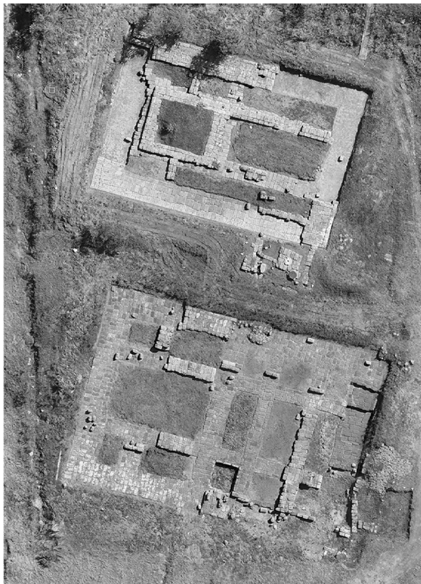
Fig. 15 - Orto-foto del Santuario Monumentale dopo gli interventi di rimessa in luce delle strutture (A. Jaia, 2017).
