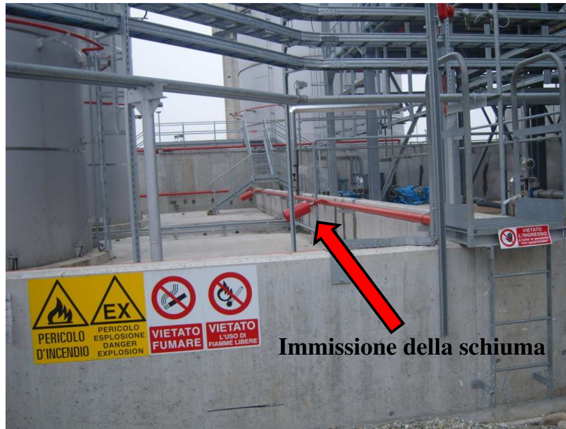
Sistema di immissione della schiuma nel bacino
