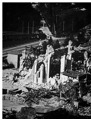
Sequenza di immagini del Duomo, da foto di Elio Ciol riprese dai piani di Santa Caterina, prima del 6 maggio 1976, dopo il primo terremoto e dopo la serie sismica del 15 settembre 1976.
