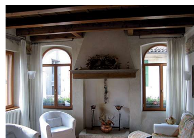
Sequenza di immagini nella stanza con il camino e l'alcova: lo stato di fatto, l'individuazione e l'apertura del camino e della finestra, la costruzione della cappa e l'immagine a casa abitata.
