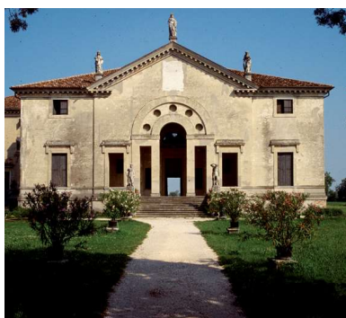
Il timpano a nord prima e dopo l'intervento, e una vista di insieme della corte di villa Saraceno.
