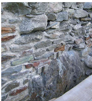
Slittamento interno per l'appoggio su una testa muraria preesistente (in alto) e, all'esterno, per l'appoggio sulla roccia inclinata (foto Giorgia Gentilini).
