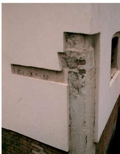
Immagini precedente e successiva al restauro di un edificio cinquecentesco a Venezia. Il bordo netto che separa la parte con l'intonaco completamente rinnovato dalla muratura basamentale mantenuta a vista, modifica profondamente l'immagine architettonica del manufatto.
