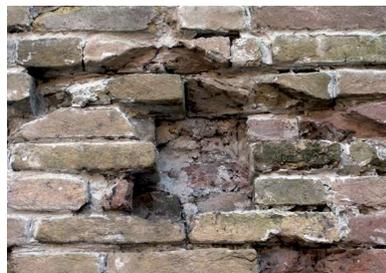
Dettaglio dell'intervento sull'interfaccia negativa formata per inserire la trave di colmo della copertura. Nell'immagine iniziale, lo stato del muro a puliture effettuate; nelle due seguenti, dopo la sigillatura dei giunti, prove a secco di integrazione con inserimento di mattoni di recupero (sopra) o di mattoni nuovi (sotto) per il sostegno dei mattoni a sbalzo. In basso, l'intervento concluso (foto di Paola Squassina).
