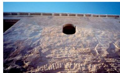
Un accorgimento per mantenere la leggibilità, sia pure attenuata, del paramento murario e delle sue articolazioni costruttive, pur senza rinunciare alla riunificazione cromatica del prospetto, può consistere nella rasatura a mezzo di un intonaco parzialmente coprente – in questo caso un cocchiopesto affine a quello conservato a tratti – sulle superfici murarie. Fianco dell'ex convento di San Cosmo a Venezia.
