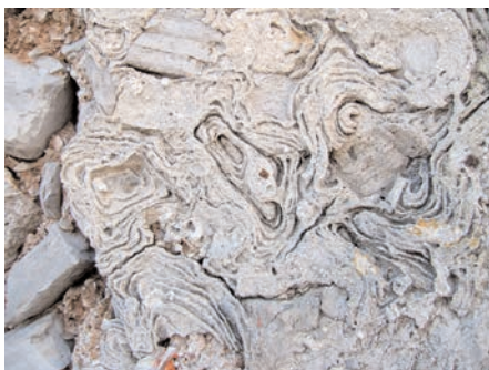
c) Un particolare attacco biologico degli intonaci è il fenomeno del flos tectoris . Nella foto un particolare di una superficie intonacata a Lussino (Croazia) (foto di F. Fratini).
