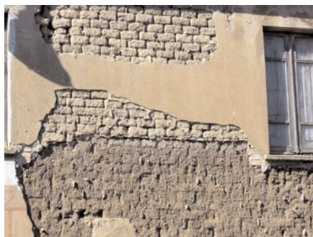
b) Murature in mattoni di terra ( adobe ) a Serrenti (Cagliari).
