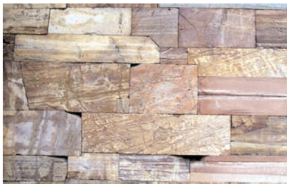
g) Muratura nel complesso del Qutb Minar di Delhi (India), del XII secolo. La muratura sembra realizzata con materiale di recupero, adattando conci molto diversi tra loro, e mostra una varietà di litotipi differenti, fra cui marmi di diverso colore.
