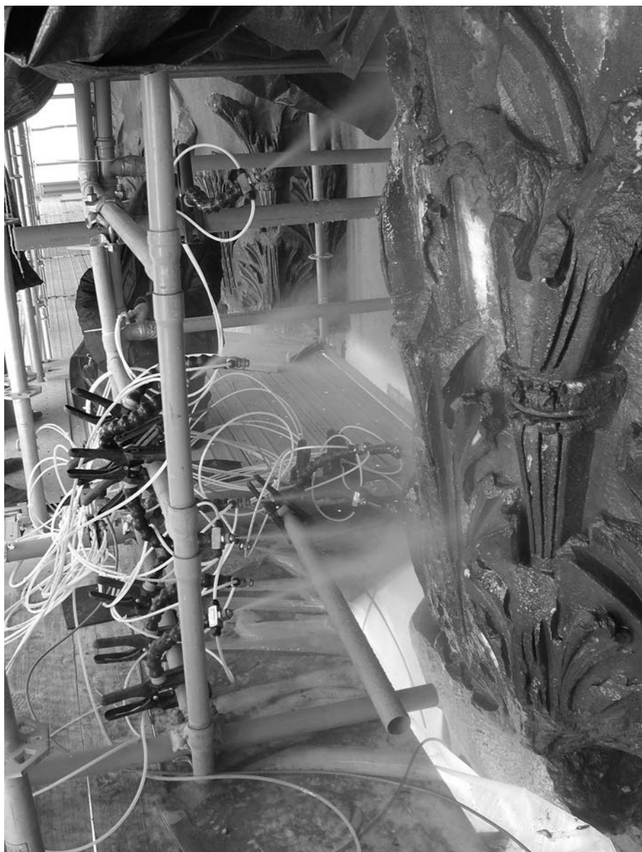
FIGURA 6.3 Roma, Tempio di Adriano. Pulitura ad acqua atomizzata
