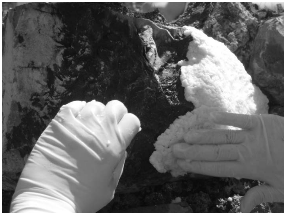
FIGURA 6.4 Sermoneta, cantiere-scuola della Specializzazione in Beni Architettonici e del Paesaggio, Università di Roma "Sapienza". Pulitura con EDTA
