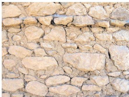
e) Malta di allettamento in terra a Lalibela (Etiopia), con inerti lapidei e fibre vegetali (foto di F. Fratini).
