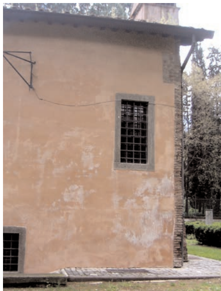
f) Degrado fisico-chimico: efflorescenze saline sull'intonaco, realizzato di recente, della Casina del cardinal Bessarione a Roma.
