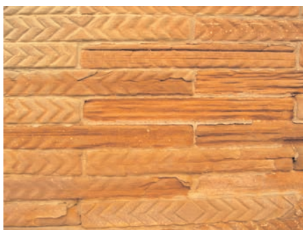
e) Muratura in arenaria rossa a Fathepur Sikri (India). La muratura, del XVI secolo, presenta conci lapidei che simulano una cortina laterizia.
