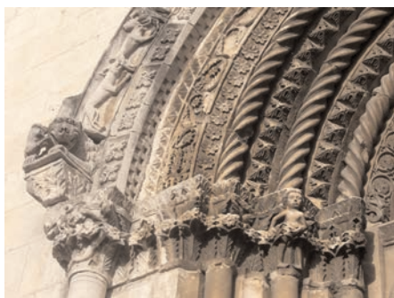
e) Degrado chimico: croste nere sul portale della chiesa di S. Maria di Paganica all'Aquila. Sono evidenti le parti dilavate, più chiare, e le parti scure, su cui si sono depositati gli elementi inquinanti.
