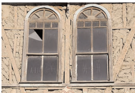
a) Murature a graticcio ligneo e riempimento in terra a Tarakli, Sakarya (Turchia).
