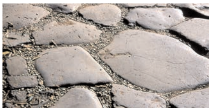
e) Lastre di basalto in un'antica pavimentazione romana (foto di M. De Meo).
