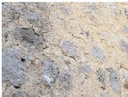
f) Malta di rivestimento, con trattamento a “raso-sasso”, su una torre della cinta muraria di Castelvecchio di San Gimignano (Siena). Le fessurazioni dovute al ritiro sono tipiche delle malte di calce aerea e non sono da considerarsi un fenomeno di degrado.
