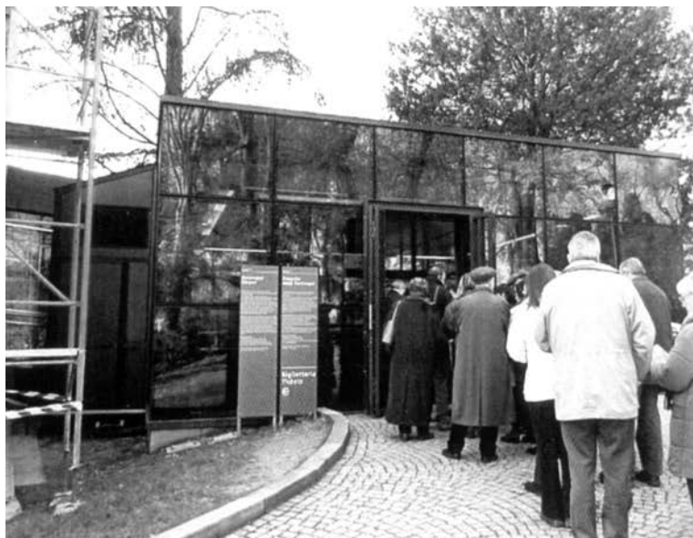
FIGURA 4.2 I Padova, cappella degli Scrovegni. Vedute del corpo tecnologico attrezzato
