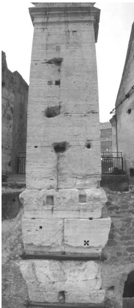
FIGURA 5.23 Roma, Colosseo. Vista interna del pilastro 1 (fornice 18)
