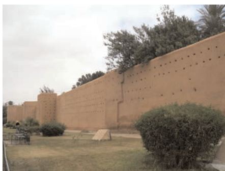
c) Cinta muraria in terra pressata ( pisé ) nella città di Marrakech (Marocco). Le mura, che hanno subito vari rifacimenti, risalgono al XII secolo.
