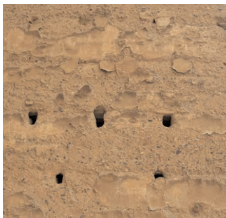
d) Muratura in terra pressata ( pisé ) del Palais El Badia, del XVI secolo, a Marrakech (Marocco).
