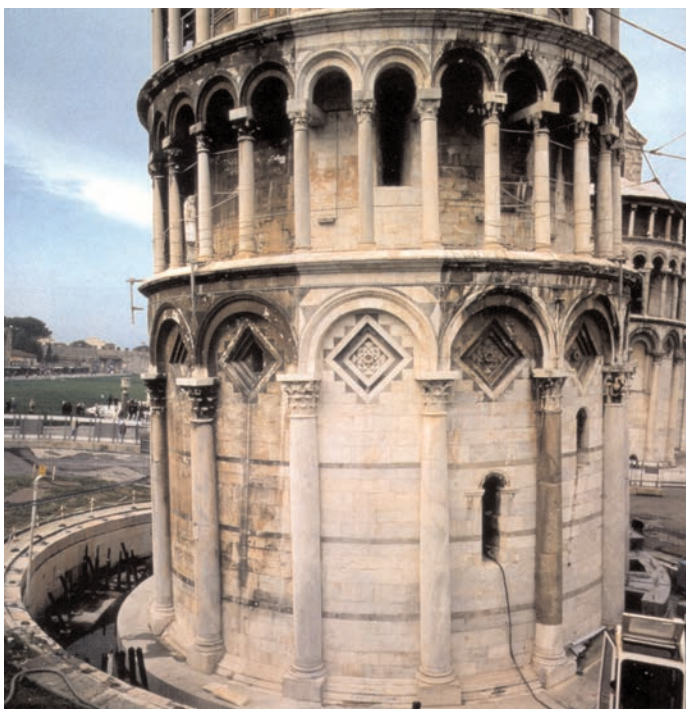
b) Uno dei tasselli scelti per il "cantier di progetto" ripreso al termine delle operazioni di restauro. L'immagine costituisce un efficace accostamento della situazione ante operam al risultato finale; è ben visibile, specialmente nel loggiato del secondo ordine, la cura con cui sono state conservate le patine stese dal tempo sulle superfici del monumento (da D'Elia, Capponi, 2005).
