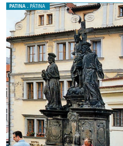
This sandstone sculpture, originally of light colour, has developed an iron rich patina over time. Esta escultura en arenisca, originalmente de tonos claros, ha desarrollado una pátina ferruginosa con el tiempo.
