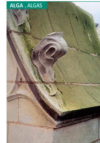
Green algae growing on a limestone buttress. Algas verdes creciendo en un contrafuerte en calizas.
