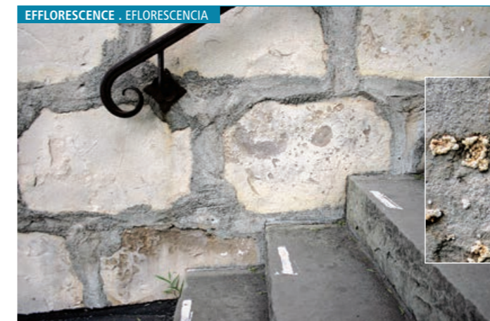
Limestone block showing salt efflorescences . Bloque de caliza mostrando eflorescencias salinas.
