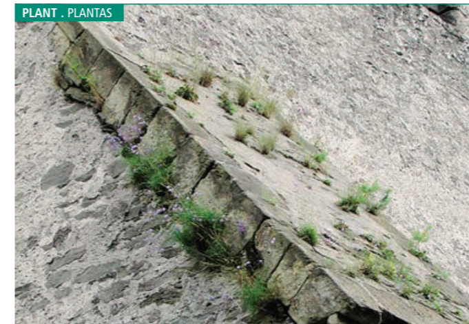
Plants growing on sandstone basalt masonry. Plantas desarrollándose sobre mampostería de piedra a base de basalto y arenisca.
