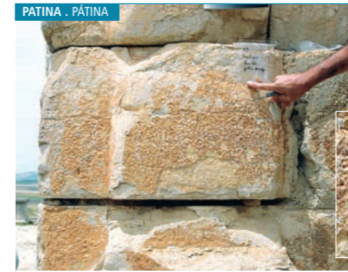
Oxalate patina developing on limestone. Pátina de oxalato desarrollada sobre una caliza.
