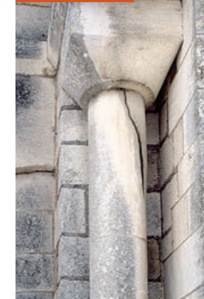
France, Saint-Benoît-sur-Loire, 1996. Fracture length : 30cm. CICRP / P. Bromblet
