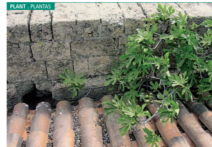
Higher plant (Fig tree) growing on a roof. Planta superior (higuera) creciendo sobre el tejado.
