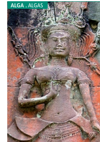
Red algae on a bas-relief sandstone sculpture. Algas rojas en el bajorrelieve de una escultura en arenisca.
