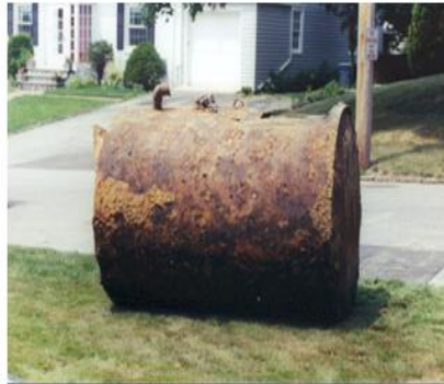
Rimozione di serbatoi di carburante interrati
