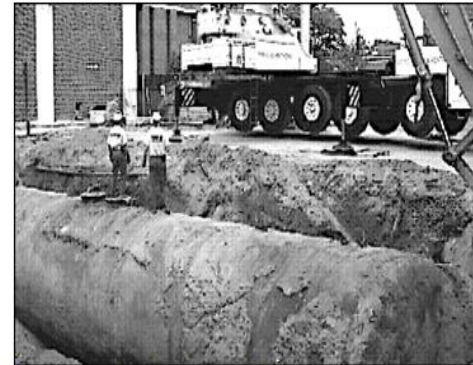
Rimozione di serbatoi di carburante interrati
