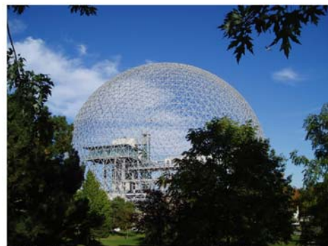
La Biosfera di Montreal, in precedenza padiglione americano all'Expo 67, di R. Buckminster Fuller, sull'Isola di Sainte-Hélène a Montreal. È un esempio di applicazione in architettura della cupola geodetica.
