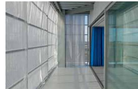
In questa pagina: il doppio spazio esterno sostenuto da una leggera struttura metallica in ferro zincato a caldo e solai in pannelli di alluminio corrugato schiumato. La facciata perimetrale è coperta con lamiera metallica ondulata preverniciata. Alle pagine 36-37: la trasparenza dei parapetti vetriati permette una vista a tutt'altezza sul paesaggio circostante
