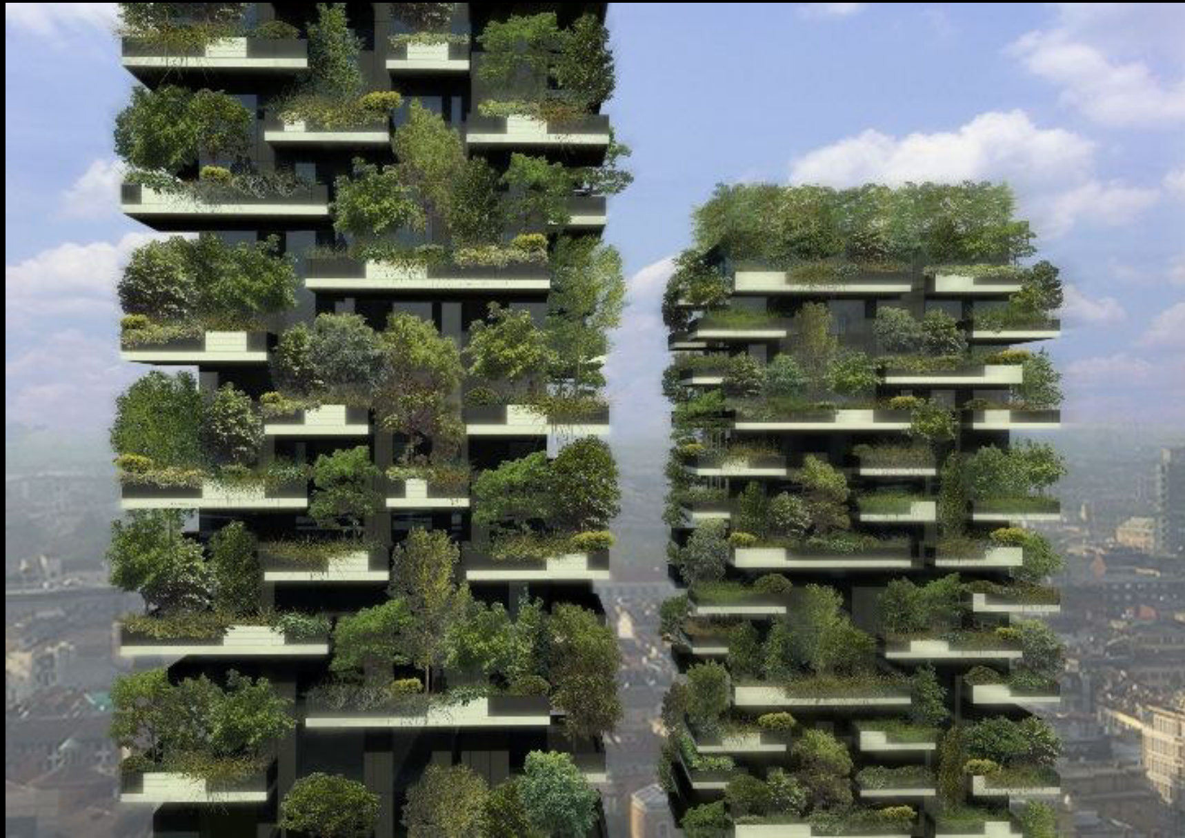
2. La crescita dell'edificio vegetale – l'architettura verde Bosco verticale, studio Boeri, Milano
