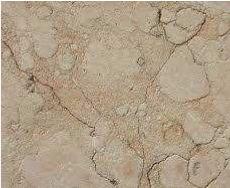
Fessurazioni in una breccia dovute all'azione di cicli di dilatazione/contrazione termica differenziale tra clasti e cemento.
