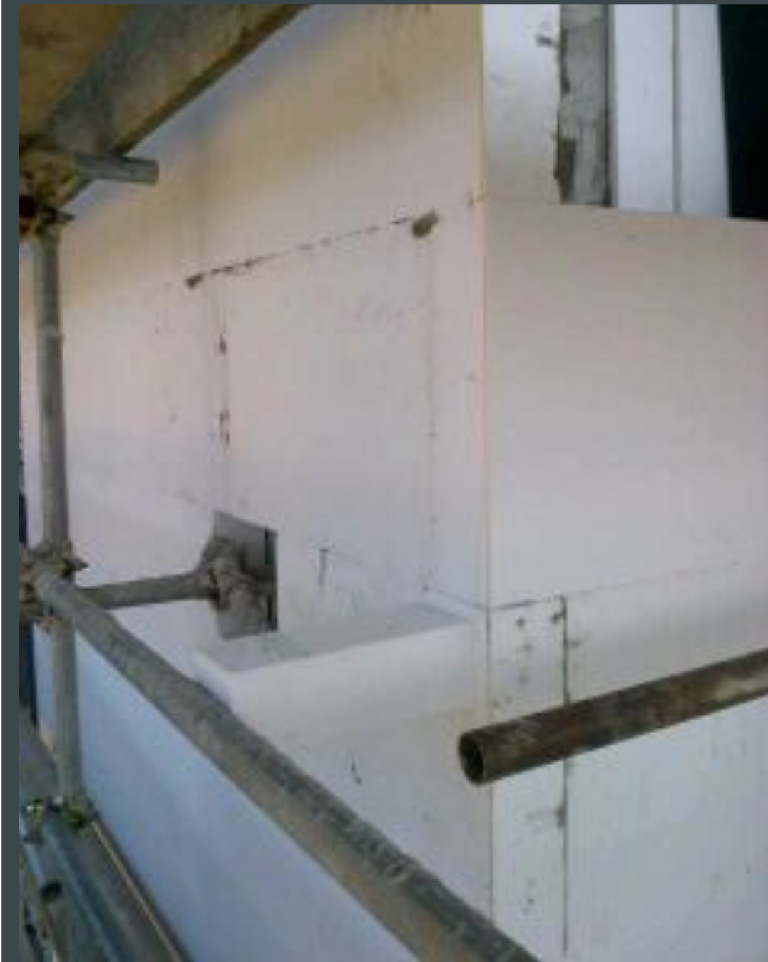
Posa del pannello isolante
