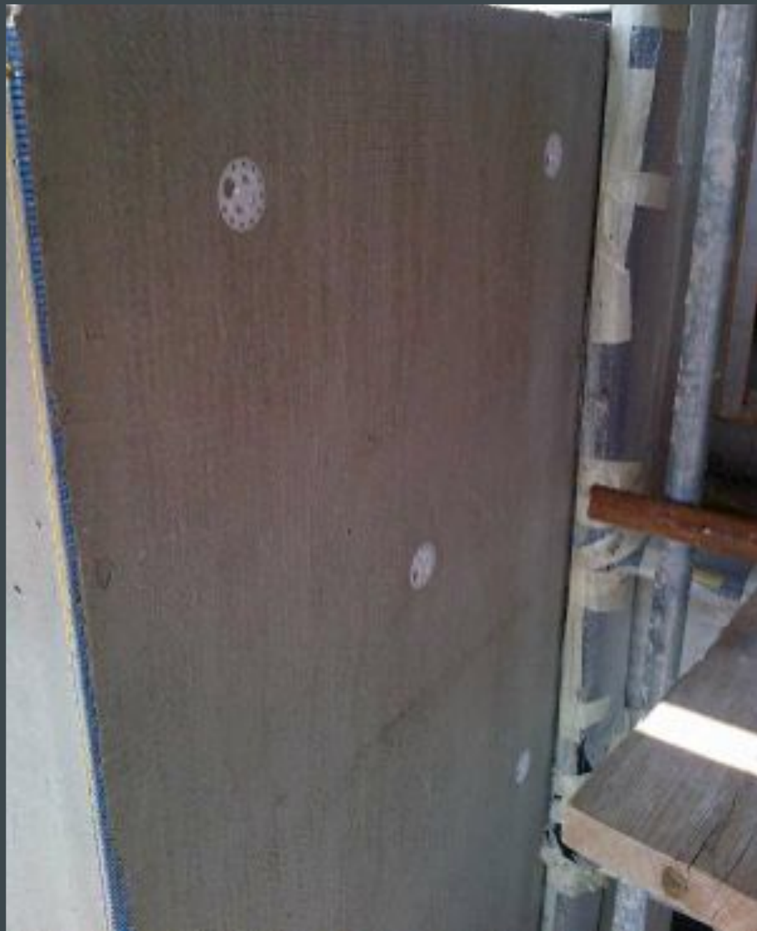
Realizzazione dello strato di intonaco fibrorinforzato
