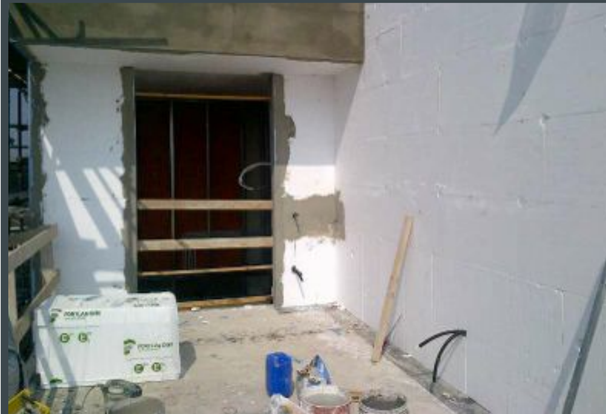
Posa del pannello isolante
