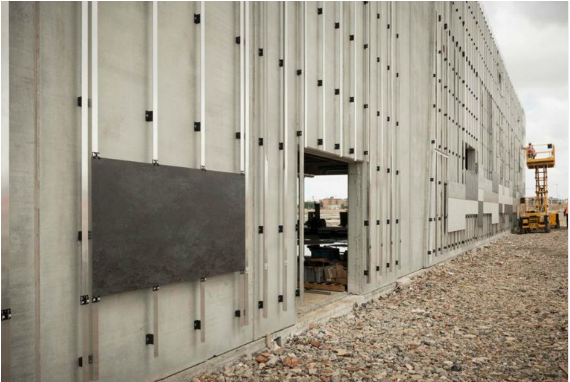
Installazione della lastra
