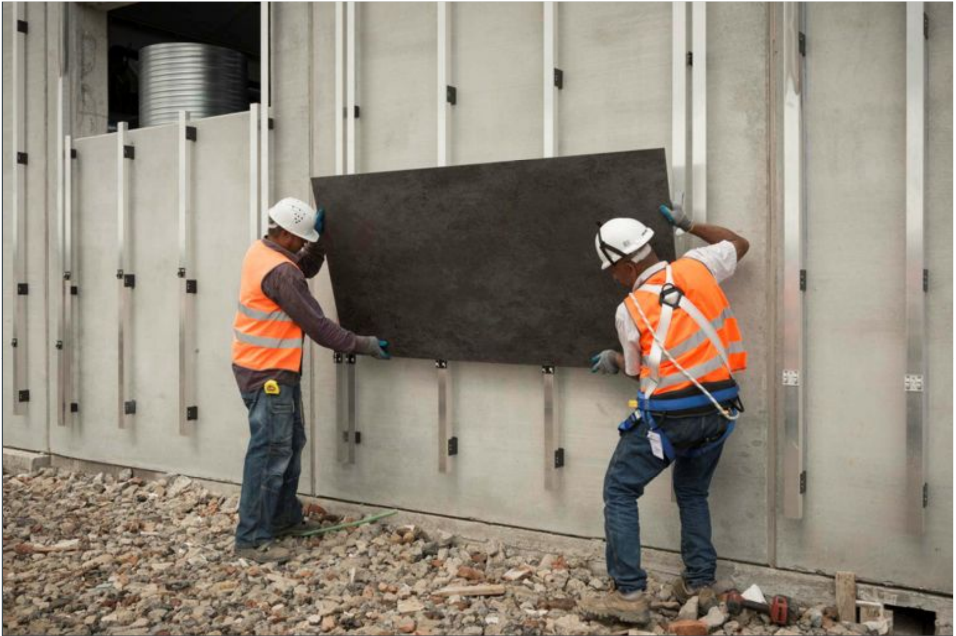
Installazione della lastra
