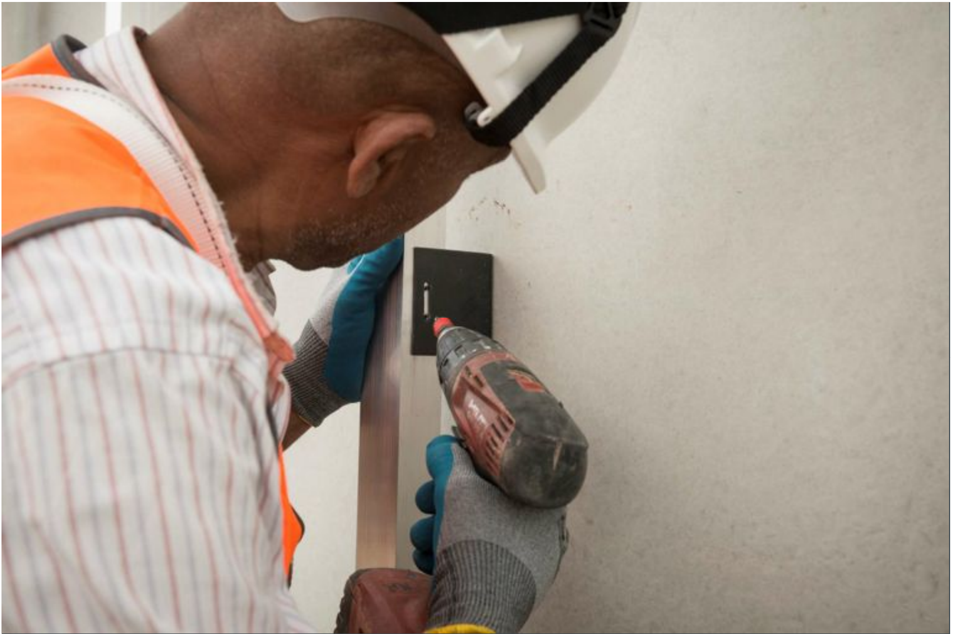
Posa della sottostruttura
