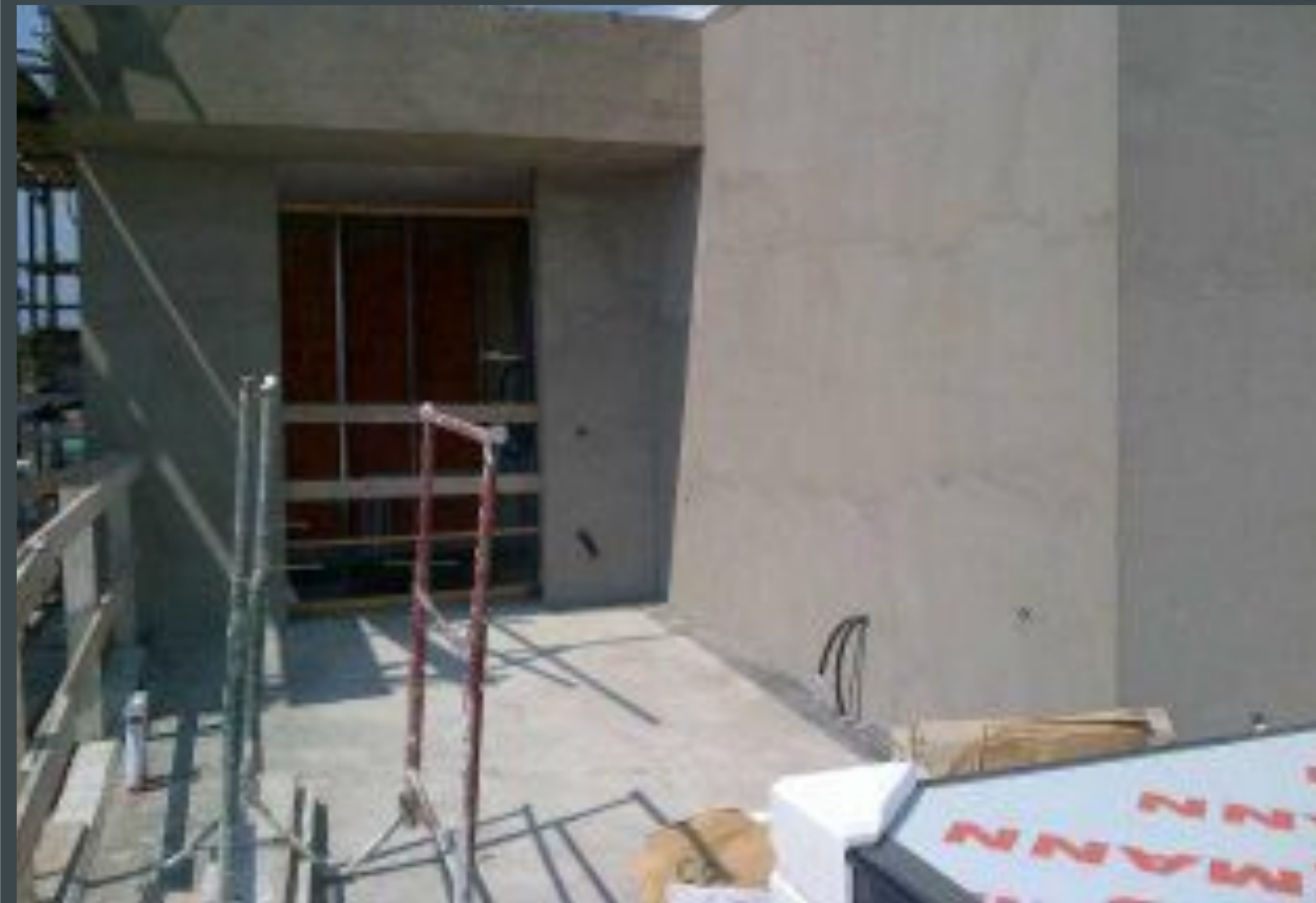
Realizzazione dello strato di intonaco fibrorinforzato
