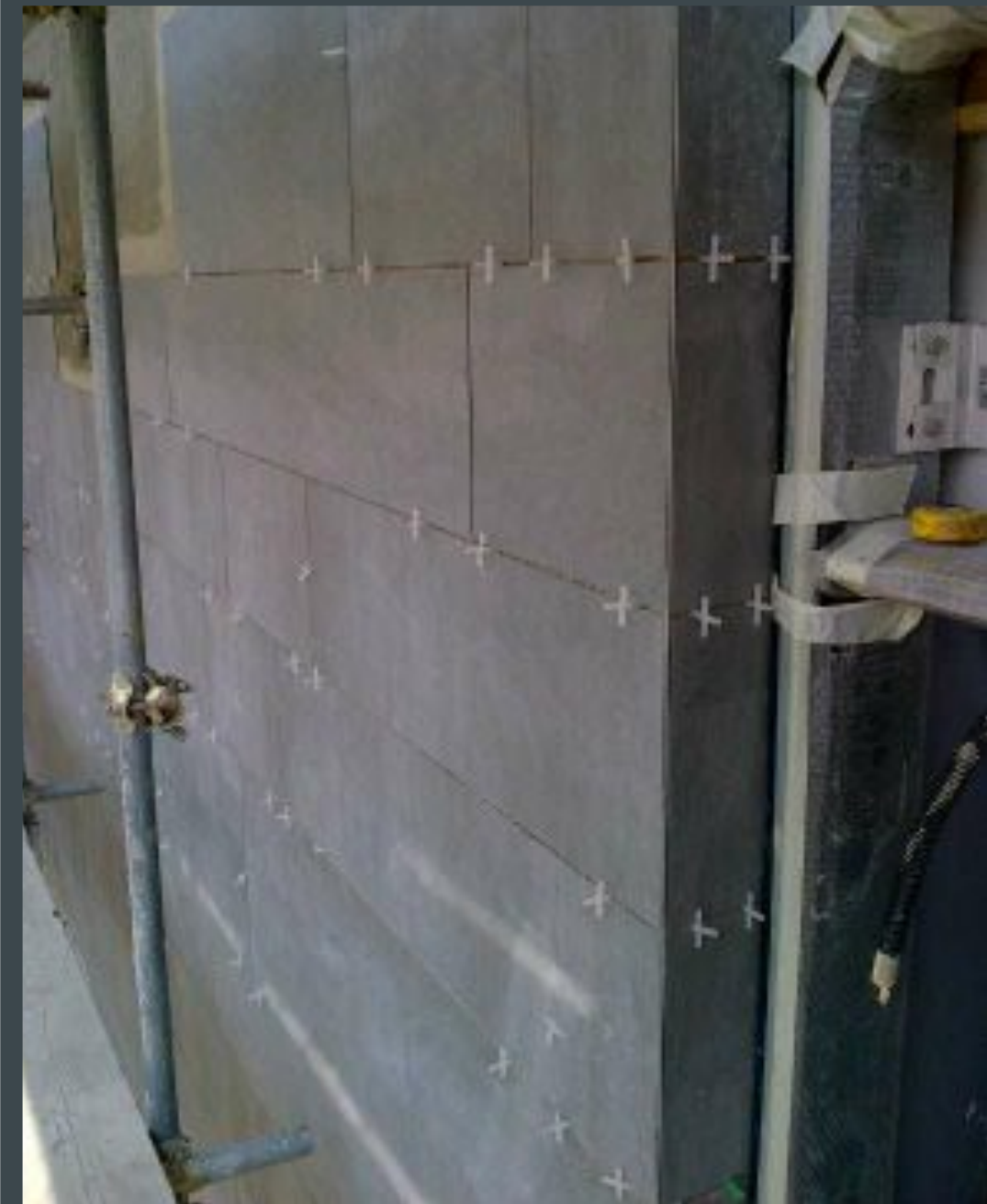
Posa del rivestimento in Laminam
